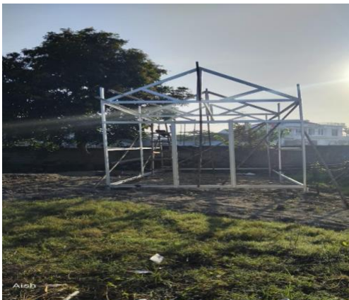
Gambar 1. Rangka Struktur Rumah Jamur
